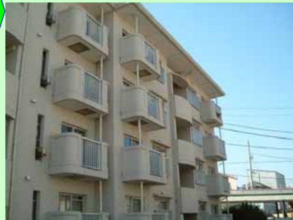
神奈川県内での外断熱改修事例写真
