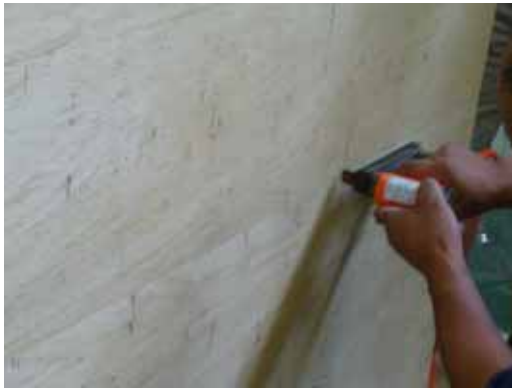
写真2 - 2 2 背板タッカー留め
