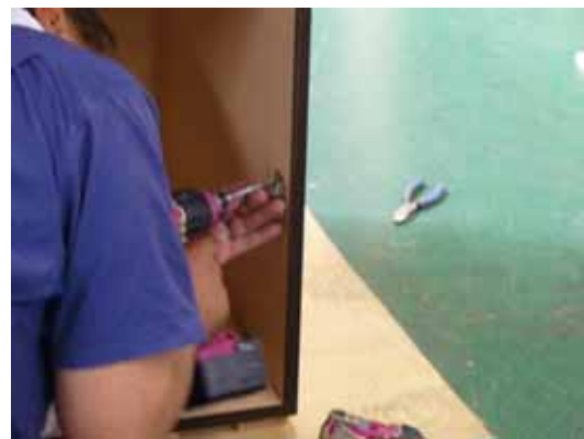
写真2 - 2 5 扉の取り付け作業
