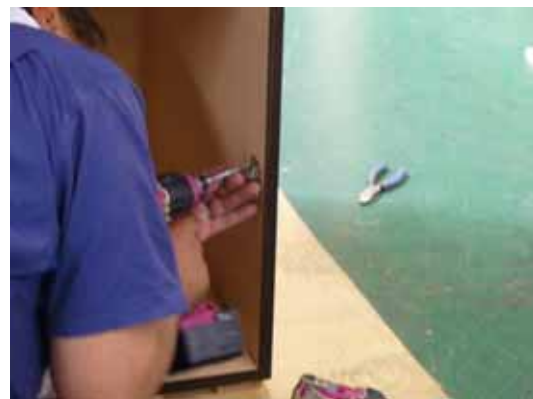
写真 2 - 2 5 扉の取り付け作業
