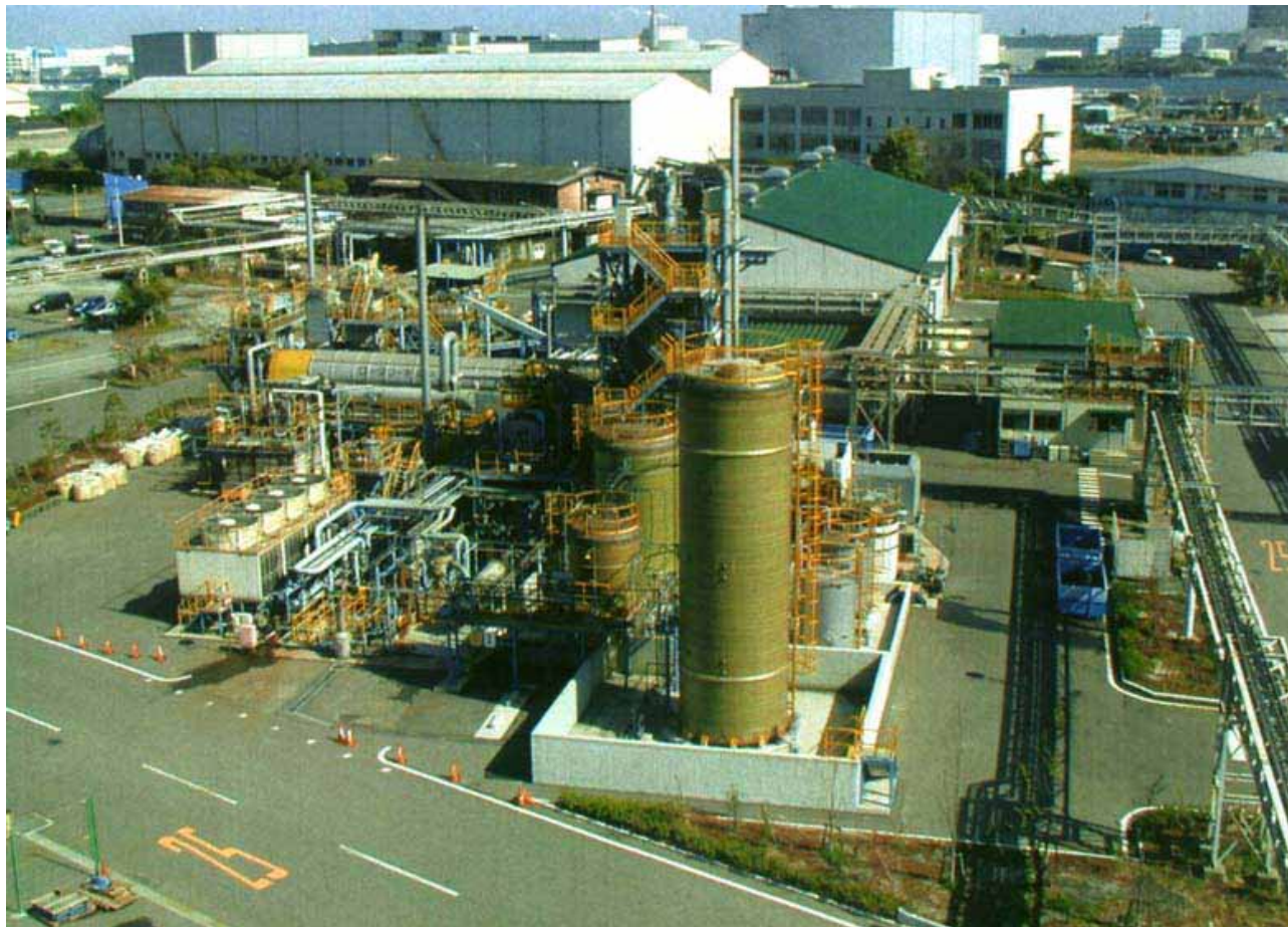
写真 2.4.1 塩ビ高炉原料化リサイクル設備(JFE スチール(株)パンフレットより)
