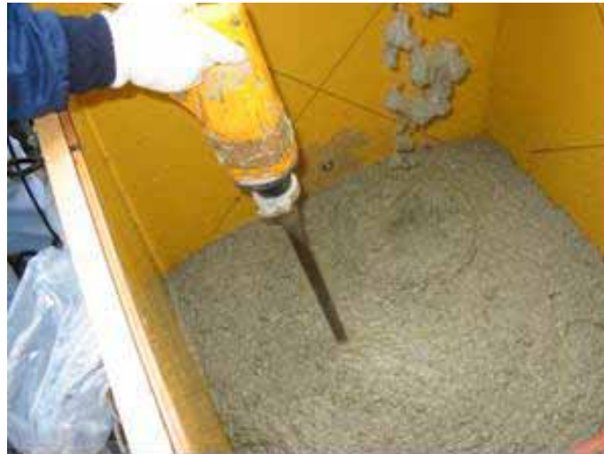
写真 3.3.22 コンクリートの打設状況
