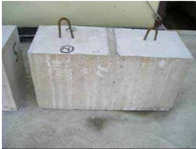
写真 3.3.6 コンクリート表面の仕上がり状況
