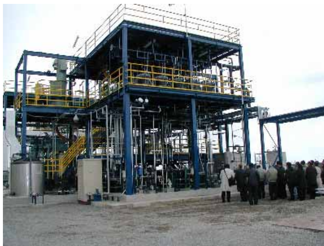
写真 4.3.3 リグノフェノール製造装置外観
