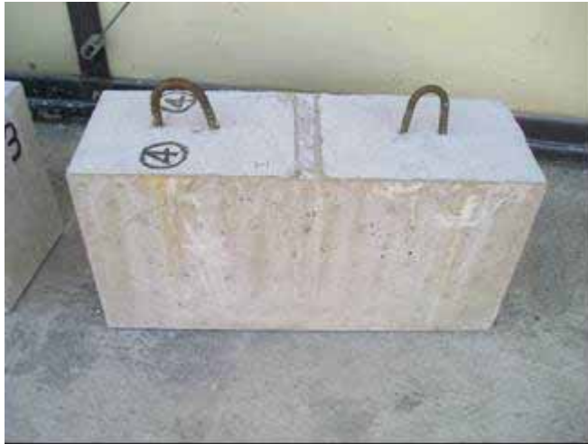
写真 3.3.8 コンクリート表面の仕上がり状況
