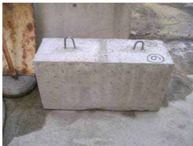
写真 3.3.10 コンクリート表面の仕上がり状況
