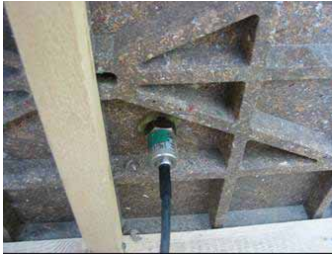
写真 3.3.4 側圧計の設置状況
