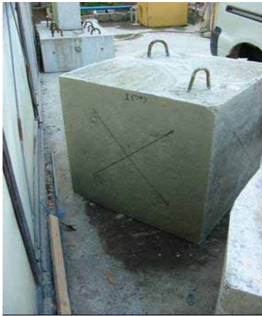
写真 3.3.23 コンクリートの表面状況 (廃木ボード 面)
