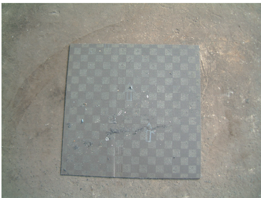
写真 4.5.3 タイルカーペット剥がし時に塩ビバック層が破損した例
