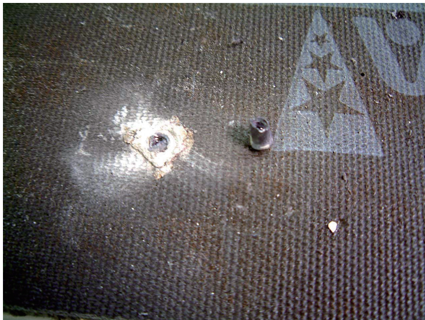
写真 4.5.2 タイルカーペットの床固定ビス
