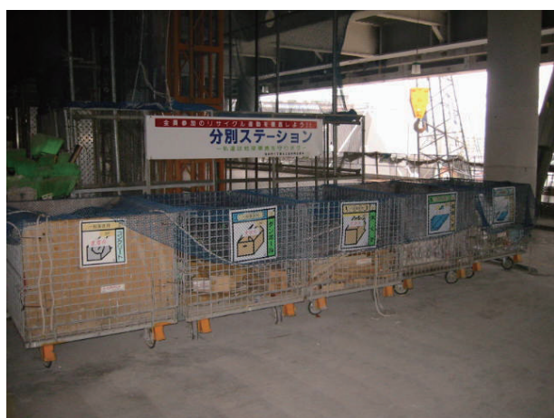
写真 5.2.1 現場内設置分別パレット
