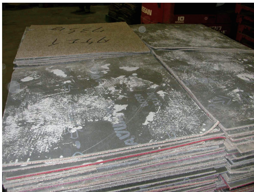
写真 4.5.1 床面モルタルが接着剤と共に剥離した例
