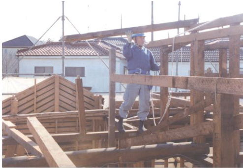
図 2.2.37 躯体材の撤去作業
