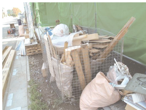
図 2.2.31 現場保管場所建設廃棄物集積状況
