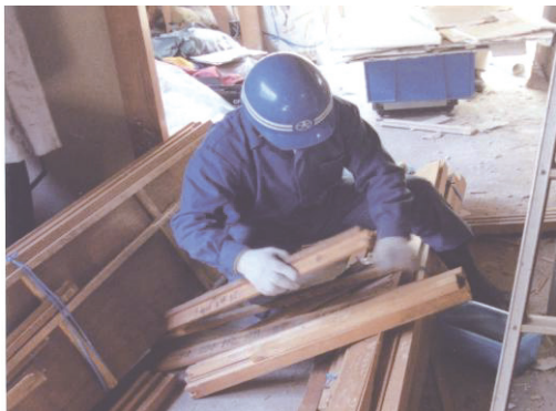
図 2.2.39 板材の集積作業
