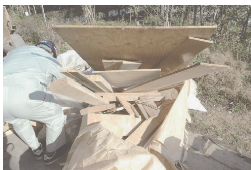
図 2.2.45 合板類、板材の端材
