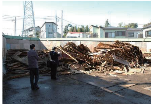
図 2.2.103 搬入された木くずの状況
