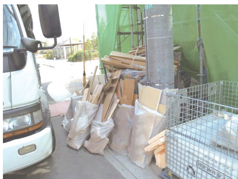
図 2.2.30 現場保管場所建設廃棄物集積状況
