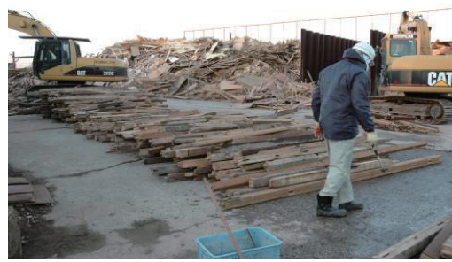
図 2.2.73 躯体材からの異物除去作業
