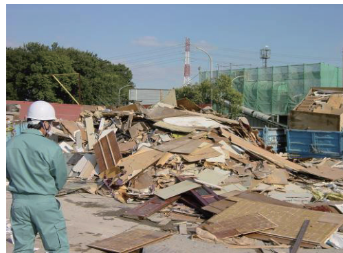
図 2.2.51 解体現場より搬入された合板類
