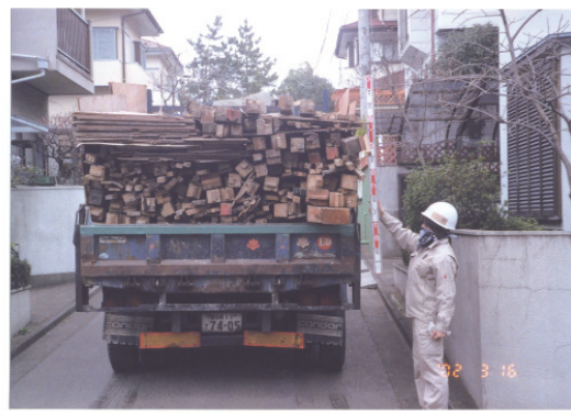
図 2.2.42 躯体材、合板類の搬出
