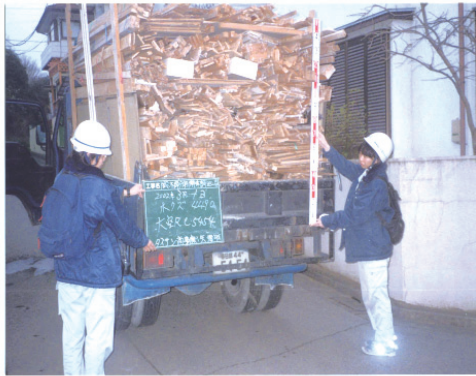
図 2.2.41 板材、合板類の搬出
