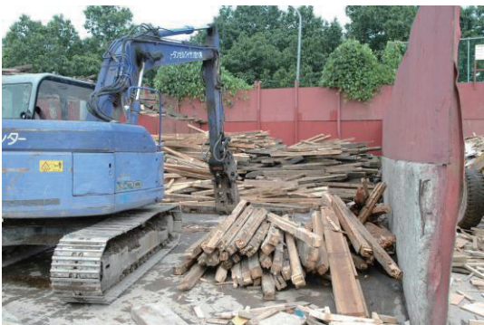
図 2.2.50 解体現場より搬入された躯体材
