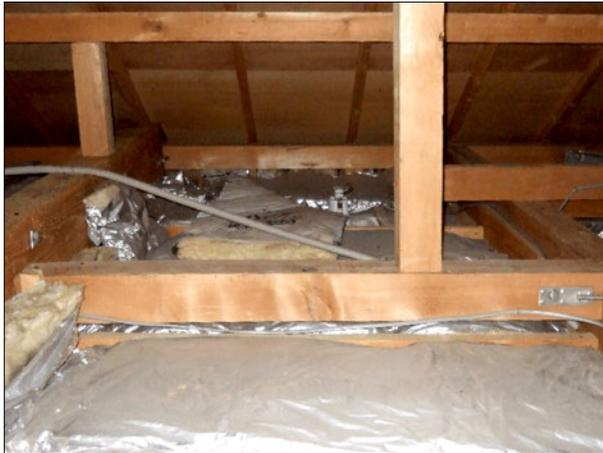
天井断熱材施工状況……隙間だらけ
