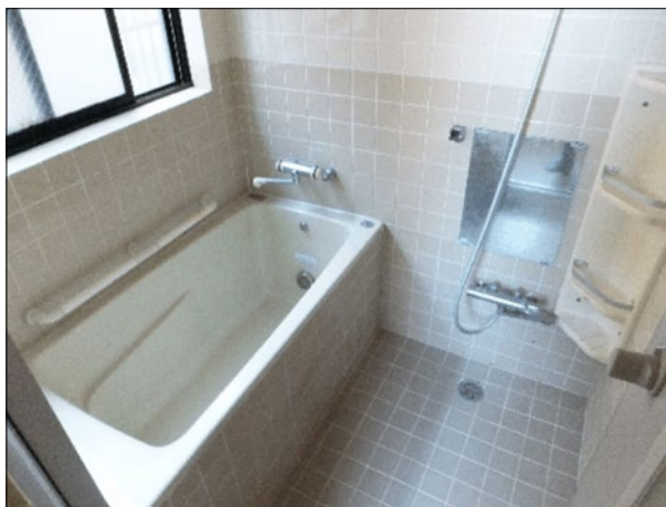
リフォーム前 (在来工法 タイル貼り)
