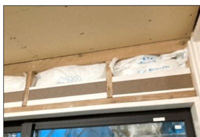
壁断熱材の施工
