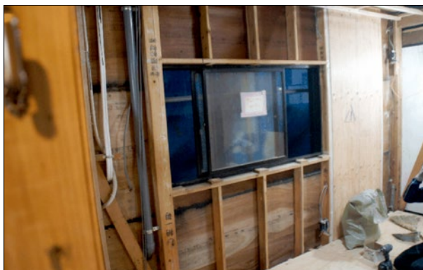
内装、断熱材を撤去し躯体の劣化を調査
