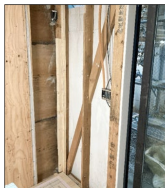
左側の合板部が補強壁
