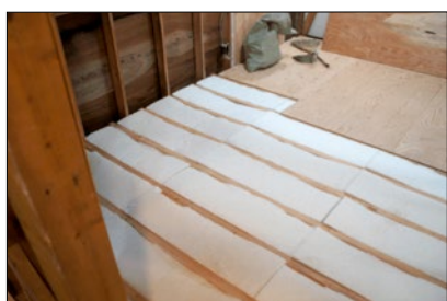
床断熱材の施工
