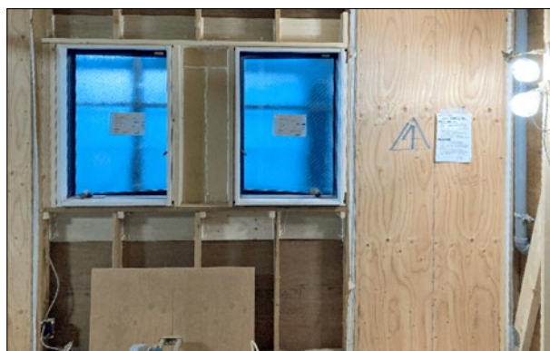
窓の左右側の合板部が補強壁
