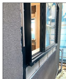
外装材の撤去・サッシの交換
