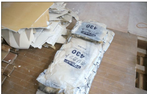
壁、2F天井裏に施工されていた断熱材
