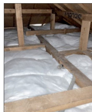
天井断熱材の施工
