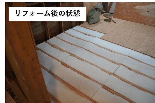
断熱材がなかったり、隙間だらけの施工だったが
