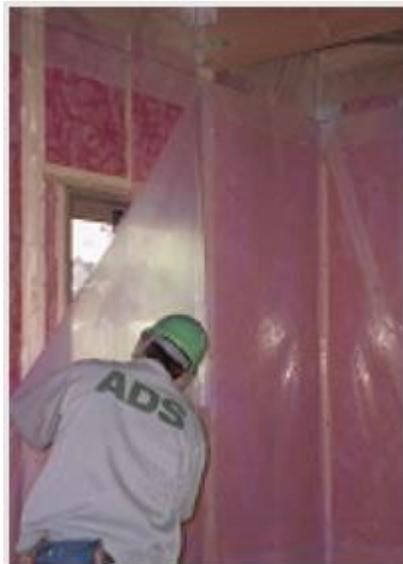
断熱材及び防湿気密シートの施工
