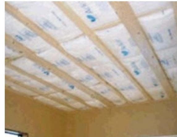
繊維系断熱材の施工は断熱材工業会などで実施されている
