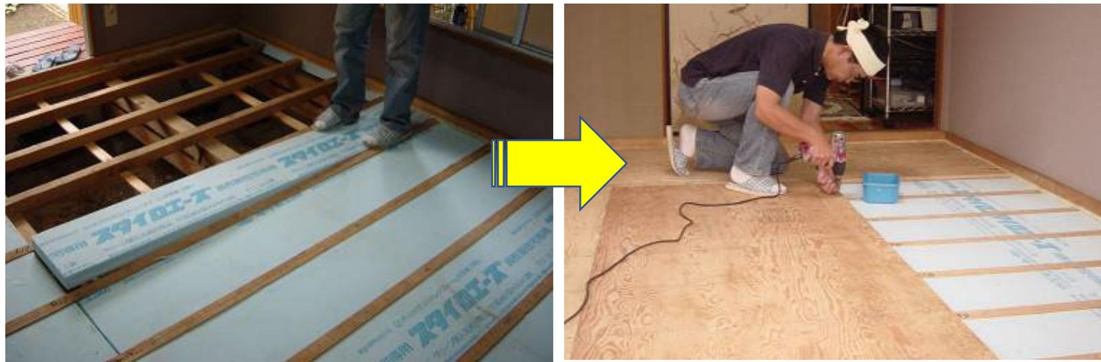
根太や大引間に発泡プラスチック系断熱材を施工する例
