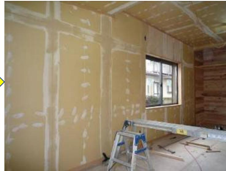
柱・間柱の間に繊維系断熱材を入れた施工例
