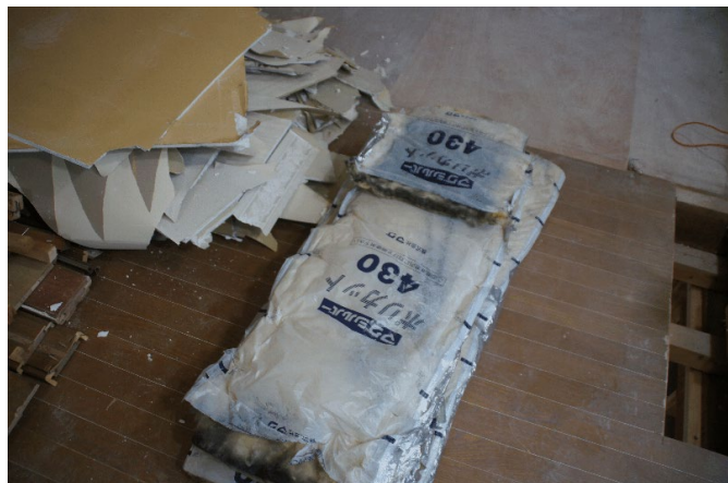
壁に施工されていた断熱材は汚れてはいるが性能は劣化していないことが確認できた
