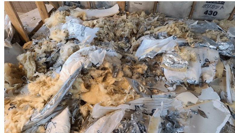
1F天井裏に施工されていた吸音材がネズミの巣になっていた
