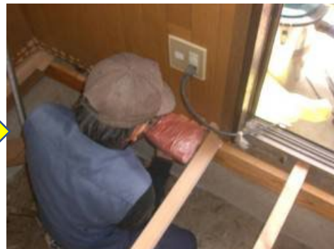
床の張り替え時に気流止めを施工例
