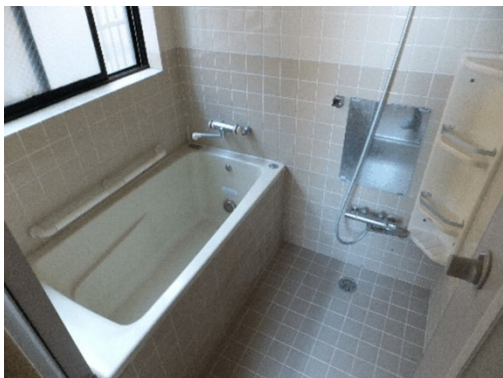
リフォーム前 無断熱浴槽+タイル貼り浴室
