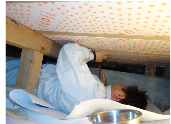
発泡プラスチック系断熱材 の施工例
