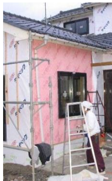
板状断熱材を用いた外張断熱リフォーム施工例
