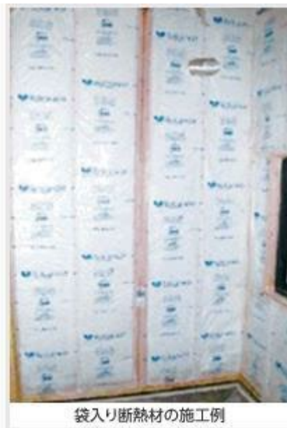
断熱材及び防湿気密シートの施工
