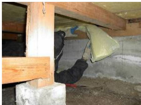
床下から気流止めを施工例
