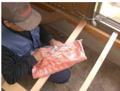
床の張り替え時に気流止めを施工例
