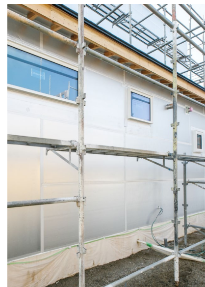
板状断熱材を用いた外張断熱リフォーム施工例
