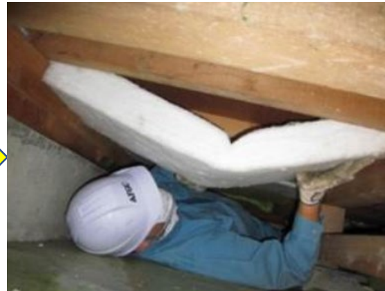
繊維系断熱材の 施工例
