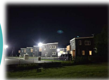
台風被害で停電したが、迅速に復旧した千葉県睦沢市
