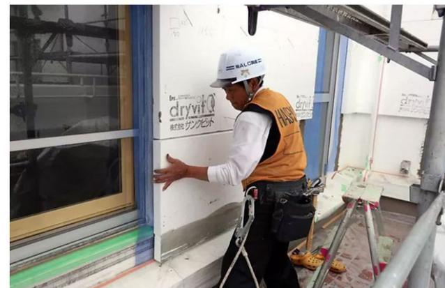
断熱材（厚さ50mm）を外壁に貼り付け
