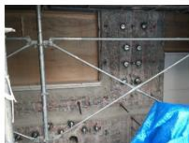
耐震壁 ジベル施工中
