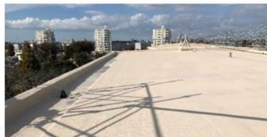
屋上防水塗装 施工後
