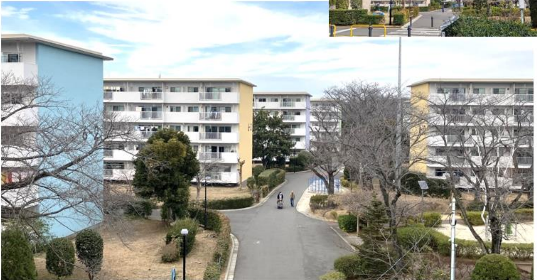
断熱改修後の街並み(南面)
