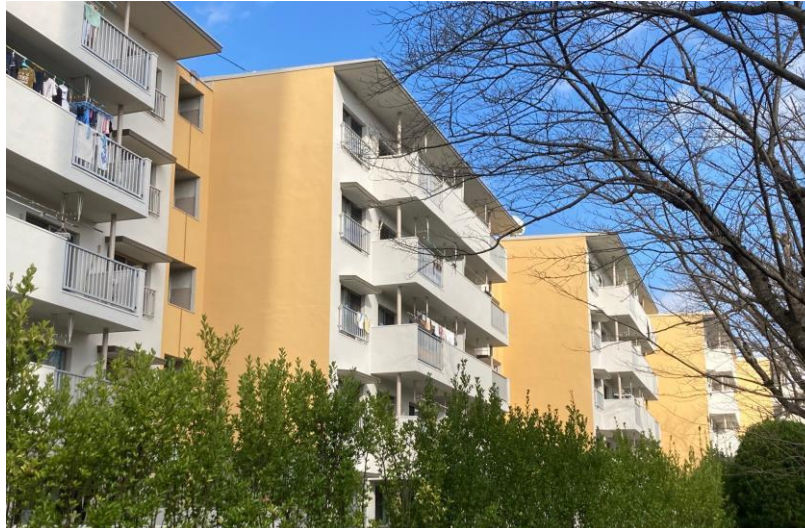
南面：バルコニー側
