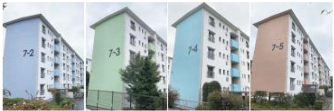
大規模修繕、カラーリングを終えた花見川住宅7街区の2～5号棟
