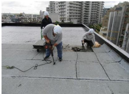
既設層の撤去
