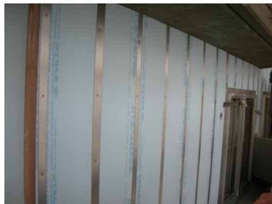
外断熱材張り付け
