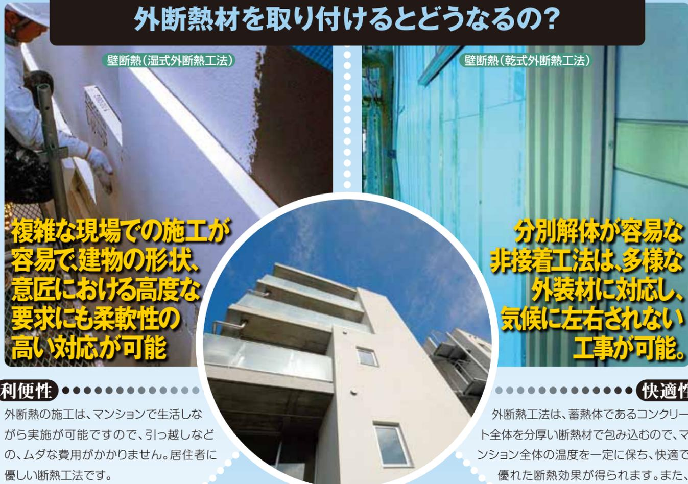
壁断熱(湿式外断熱工法)
