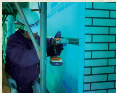
分別解体が容易な非接着工法は、多様な外装材に対応し、気候に左右されない工事が可能
