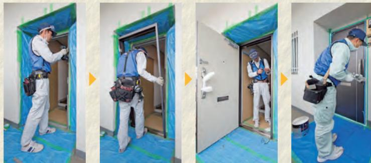
①下地取付 ②新規玄関枠取付 ③扉吊り込み金物取付 ④枠回りシーリング
