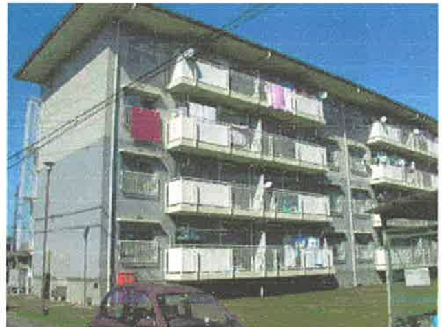
2号棟の南側からの全景
