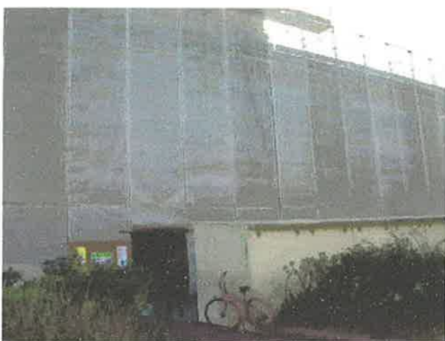
改修工事中の4号棟 (2/26現在)
