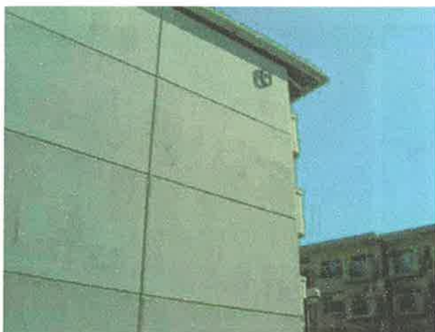
未改修の6号棟は妻面が8分割され目地が切られていることが確認できる
