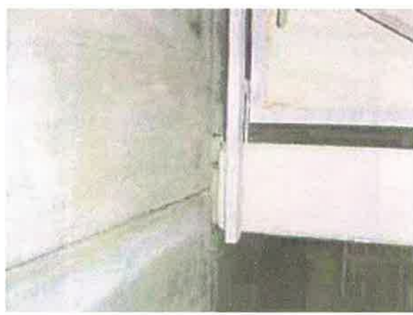
バルコニーの躯体との接合部
