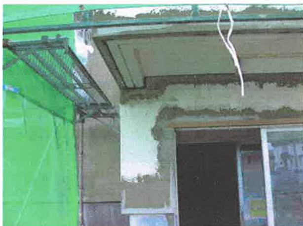
入口部の補修状況
