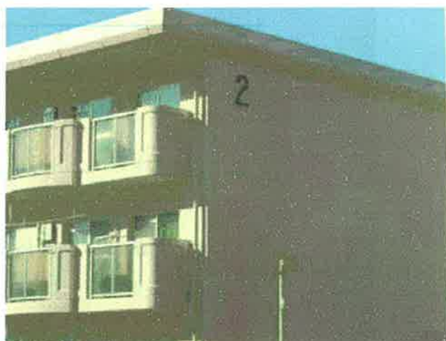
改修後の2号棟
