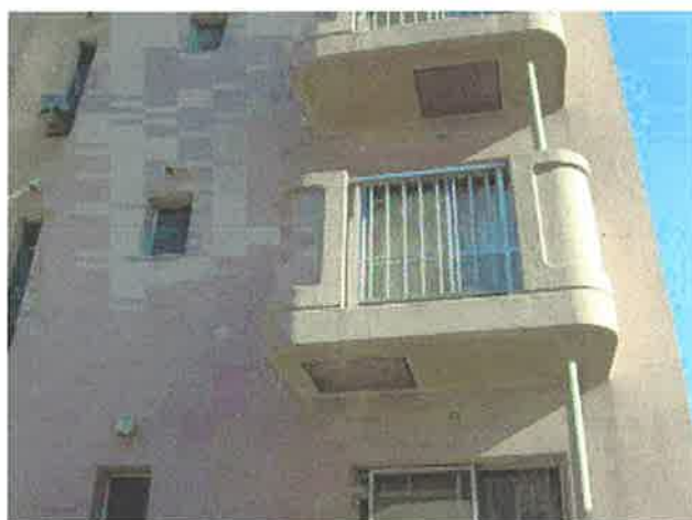
3号棟裏側バルコニー改修後
