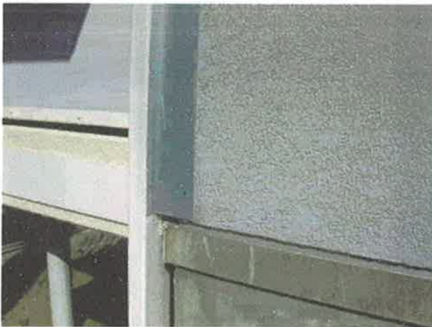
バルコニーの躯体との接合部
