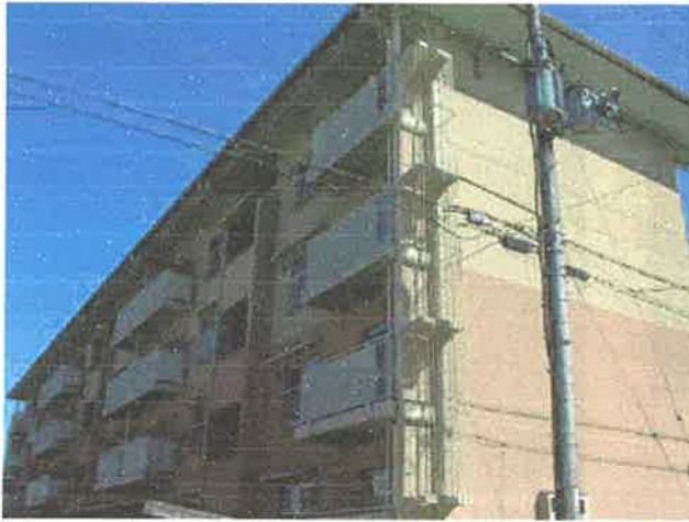
1号棟の北側からの全景
