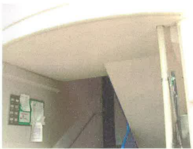
階段室の改修後
