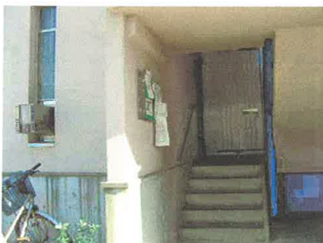
階段室の外断熱改修後、基礎部からの立ち上がりがよくわかる。
