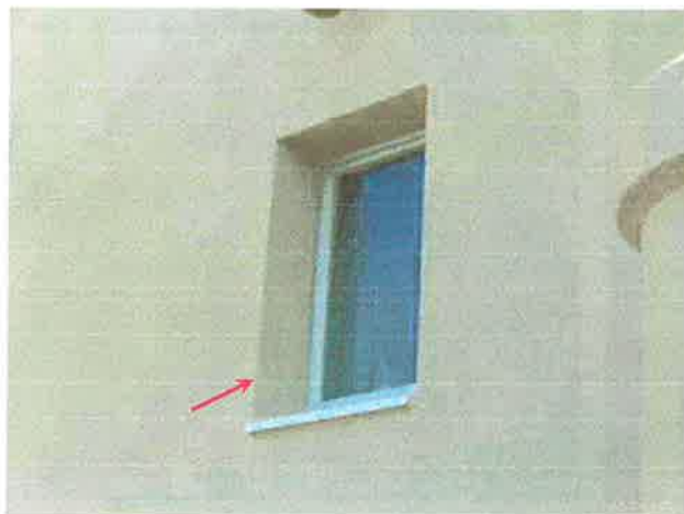
3号棟西側より小窓の段差は断熱材の厚みがよくわかる。
