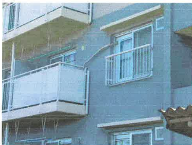
エアコンの室外機への配管のため窓にアタッチメントを設置している
