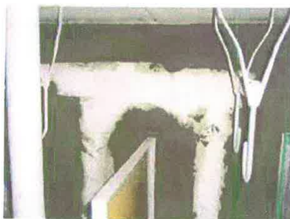
バルコニーの仕切り部
