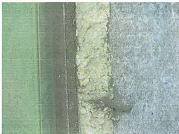
既存の断熱材
