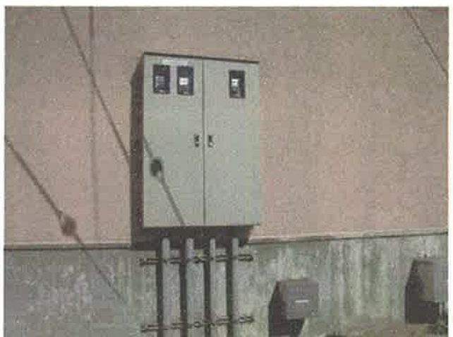
1号棟の電気の引込み線を地中化した
