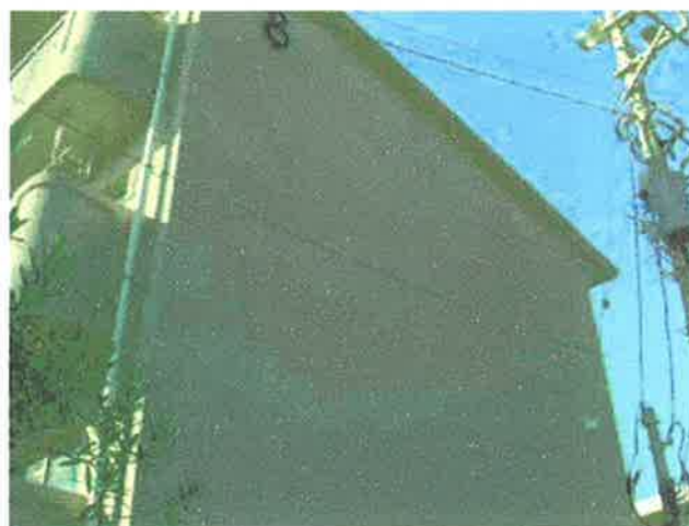
外断熱改修後の8号棟妻側は一体で目地はないことが確認できる
