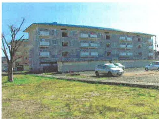
北側駐車場から2号棟を望む
