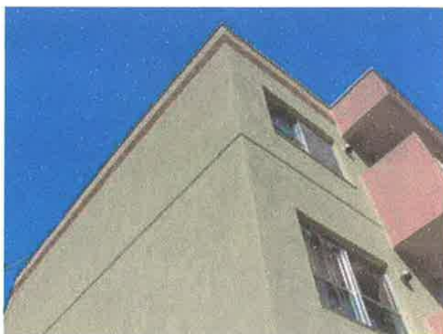
角部屋の状況
