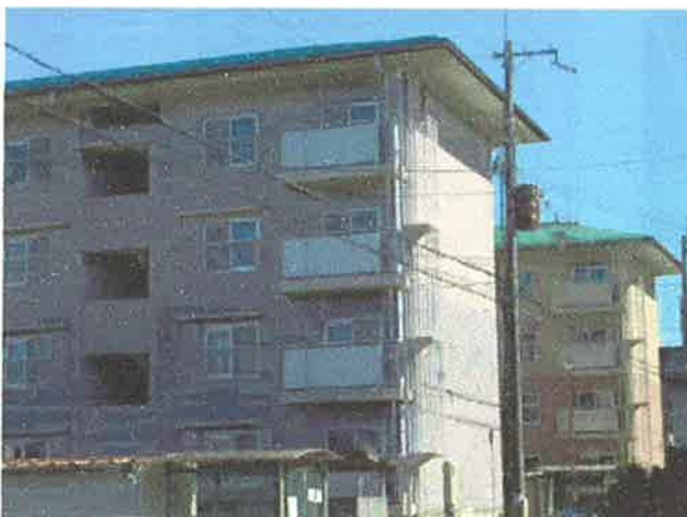
1号棟・2号棟とも屋根の新設部分を望む
