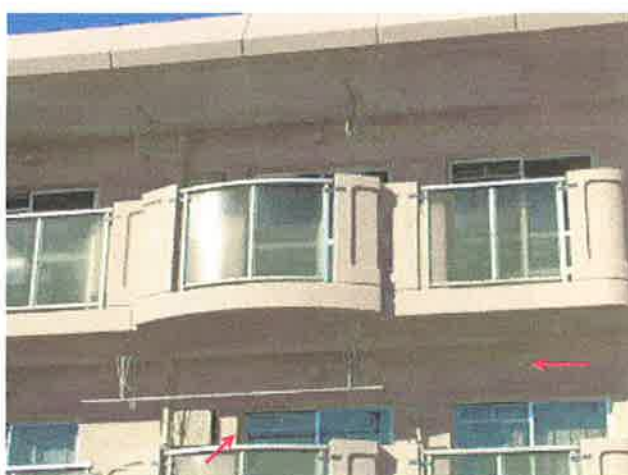
窓は換気小窓付きで、窓の上部に吸気穴が確認できる。
