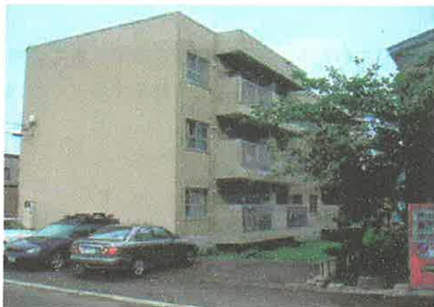
南西側道路よりの全景
