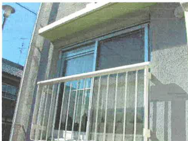
複層ガラスサッシは換気装置付き
