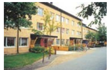
手が加えられた住棟のエントランス(入口)周り
