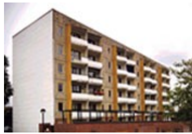
元はのっぺらぼうの無味乾燥な5階建てパネル建築を3階建てに減築、外層デザインを一新し、テラス部分を増築、1階部には専用庭を設けてリニューアルした
