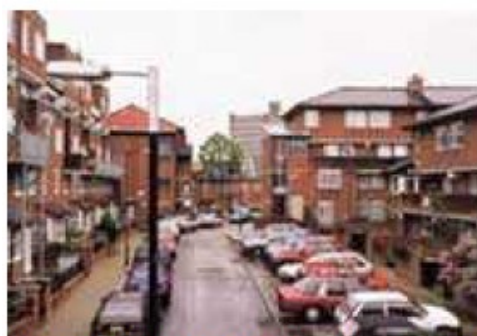
空中歩廊が取り払われたモーツァルト団地
