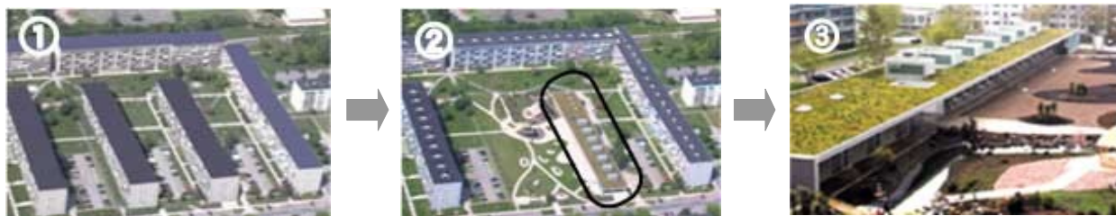
再生前の団地は、同じような住棟が規則的に並び画一的な団地形式(1)。再生プランではコの字型に住棟を残し、中央には日本庭園のある公園スペースを創出。その右の住棟は5階建てを1階建てに減築して住民センターにした(2)。住民センターは屋上緑化。もとの階段室を天窗として活かし、その下には坪庭を設置。明るいコミュニティスペースに生まれ変わった(3)
