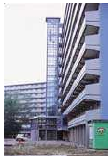
住棟を切断して不足するエレベーターを増設、外観を親しみやすくしたバイルマミア団地(角橋徹也氏撮影)
