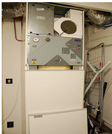
空調やヒートポンプなどの機器管理室
