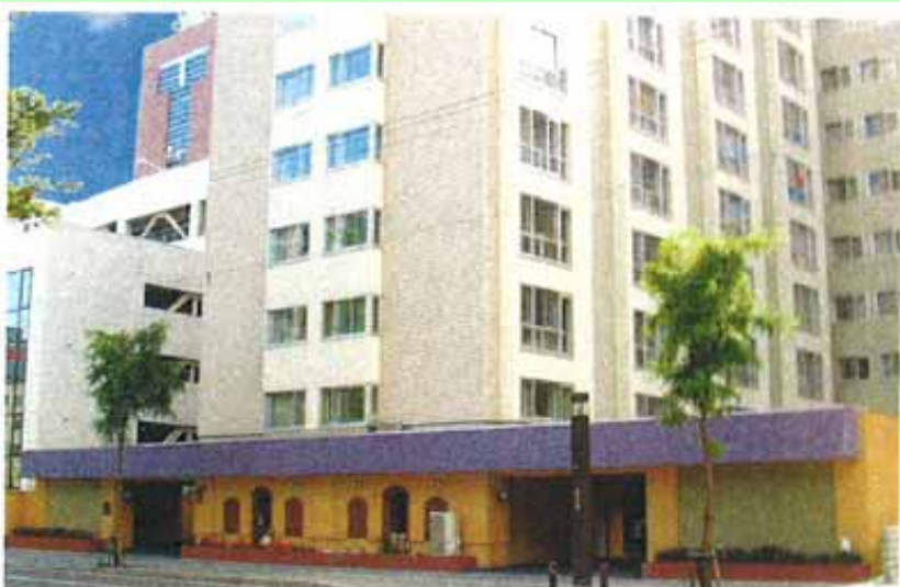
改修後－北側写真
