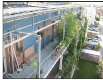
4階建ての木造集合住宅
