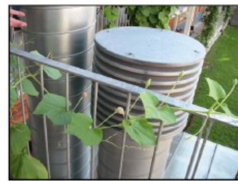
換気と集熱の配管
