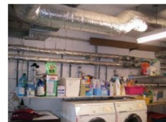
地下1階にある洗濯物乾燥器と断熱処理された集熱パイプ、温水パイプ
