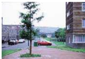
バイルマミア団地の中で、高層棟を取り壊して低層棟を建てたエリア(角橋徹也氏撮影)
