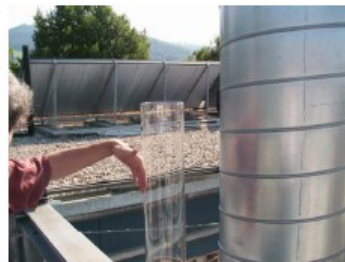
屋上まで伸びる換気と集熱の配管
