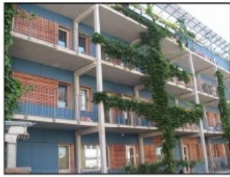
4階建ての木造集合住宅
