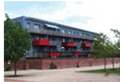
元はのっぺらぼうの無味乾燥な5階建てパネル建築を3階建てに減築、外層デザインを一新し、テラス部分を増築、1階部には専用庭を設けてリニューアルした
