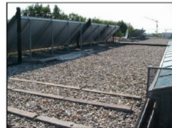
太陽集熱パネルと断熱用の砂利
