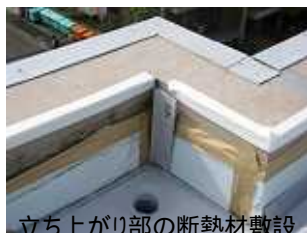
立ち上がり部の断熱材敷設
