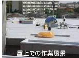
押えコンクリートの目地埋め
