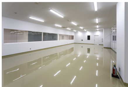
ケミクリートE 流しのペベレスト工法 #1511
