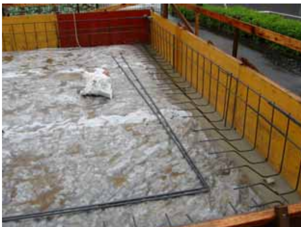
2004 年 10 月 9 日 ポリエチレンフィルムの敷設完了
