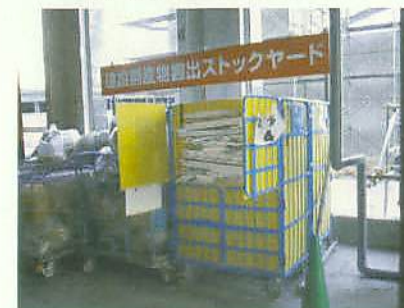
廃石膏ボード集積状況
