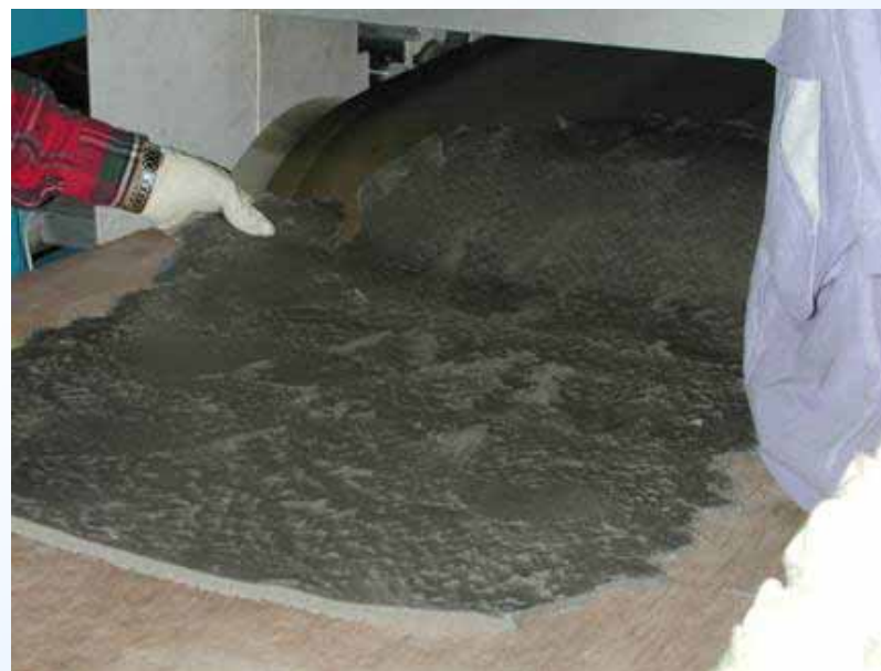
樹脂シート投入風景
