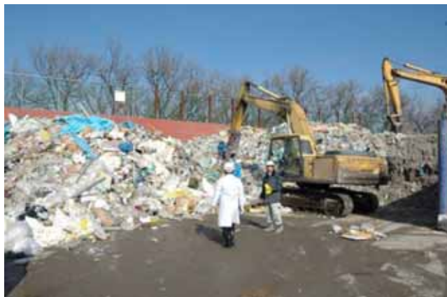
搬入荷降し時分別 (ヤード例)
