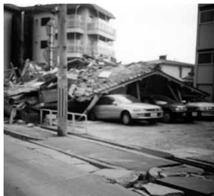
阪神・淡路大震災で倒壊した木造住宅
