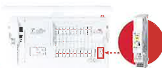
感震ブレーカー搭載の分電盤
